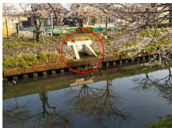
写真 3-15 水路の開口部
