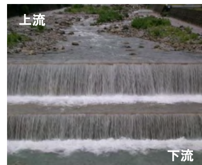
写真 3-12 ローヘッドダム
