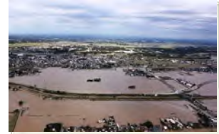
茨城県常総市 上空からの被害状況
